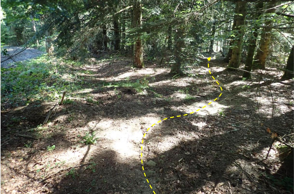
*Le fossé longeant la piste en direction de l'Estival est dégradé et ne permet plus de canaliser les eaux de ruissellement. Celles-ci débordent et s'écoulent en direction du captage, sans toutefois impacter la zone drainée. L'écoulement se fait en aval du regard.*
