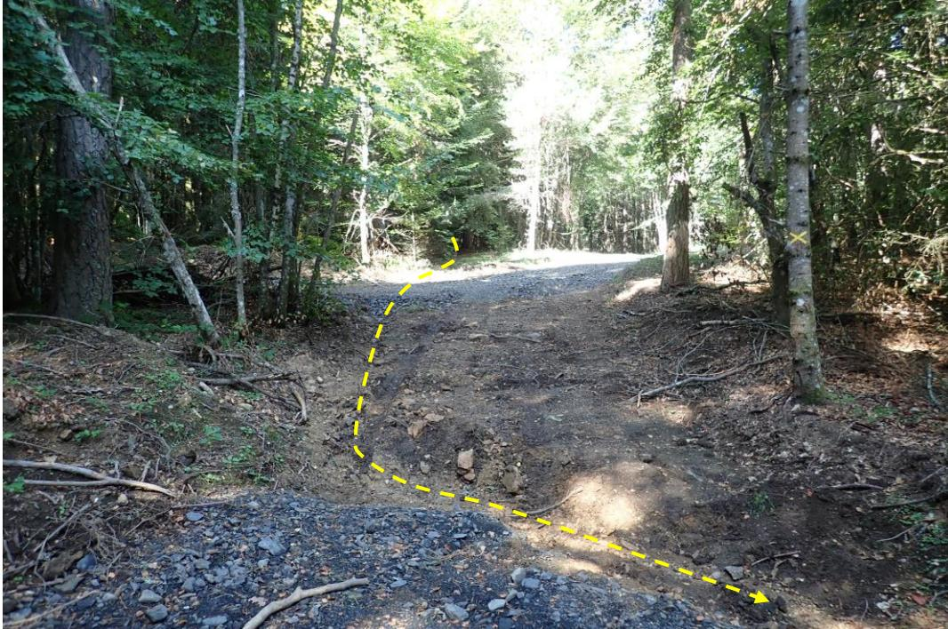
*La « patte d'oie » vue en direction de l'amont. Au premier plan la piste l'Estival-Chantelouble, au fond la piste en direction du nord-ouest. Le chemin creux se trouve dans le prolongement de la recoupe en terre du second plan. Le pointillé jaune figure le trajet principal des eaux de ruissellement. On observe nettement l'amorce de ravinement, déjà important sur la reoupe.*
